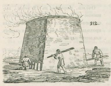
Для обжиганія сырца устроивають изъ него же, такъ-называемую, напольную печь (фиг. 212). Она внутри пустая и имъеть 5 сажень длины, 5 ширины, а въ вышину 4 аршина. Стъны ея, складенныя изъ кирпича плашмя, толщиною въ 3/4 аршина. Такая печь, устроиваемая обыкновенно на полъ, вмъщаеть въсебъ 50 тысячь кирпичей и обжигается за одинъ разъ.
